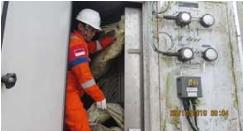
Gambar 1. Pencucian filter Sumber: Penulis – Studi lapangan, 2019
