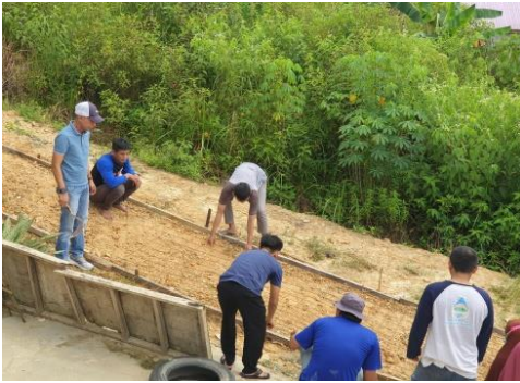
Gambar 4 Pemasangan Wiremesh dan Pengukuran Jalan untuk semenisasi
