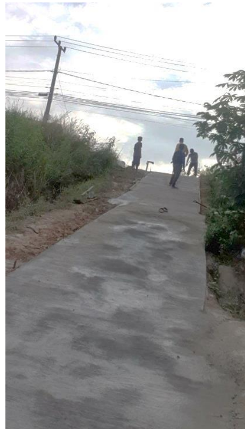
Gambar 6 hasil pembangunan sarana akses jalan
