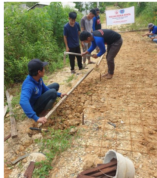
Gambar 2 Pemasangan batas kayu
