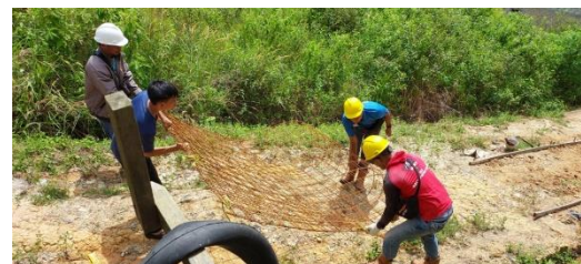
Gambar 3 Pemasangan Wiremesh oleh mahasiswa dan dospem prodi Teknik Mesin
